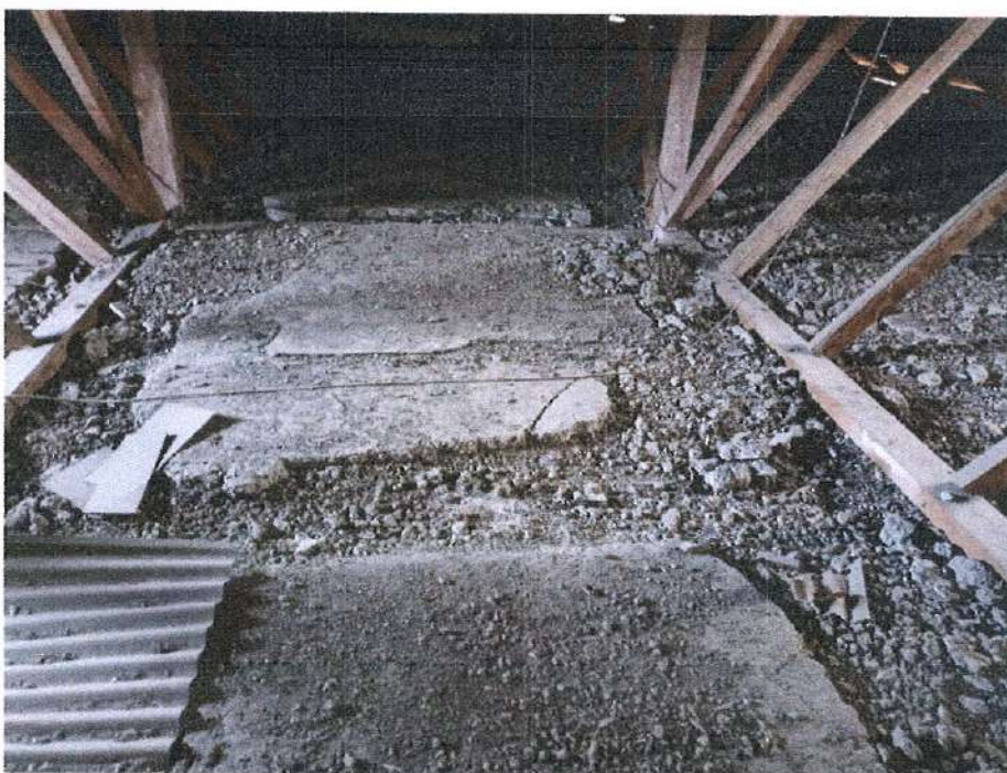
Նկ. 5 Տանիքի փայտե ծալեղային համակարգի տարրերին հենման տեղամասերի տեսքը
