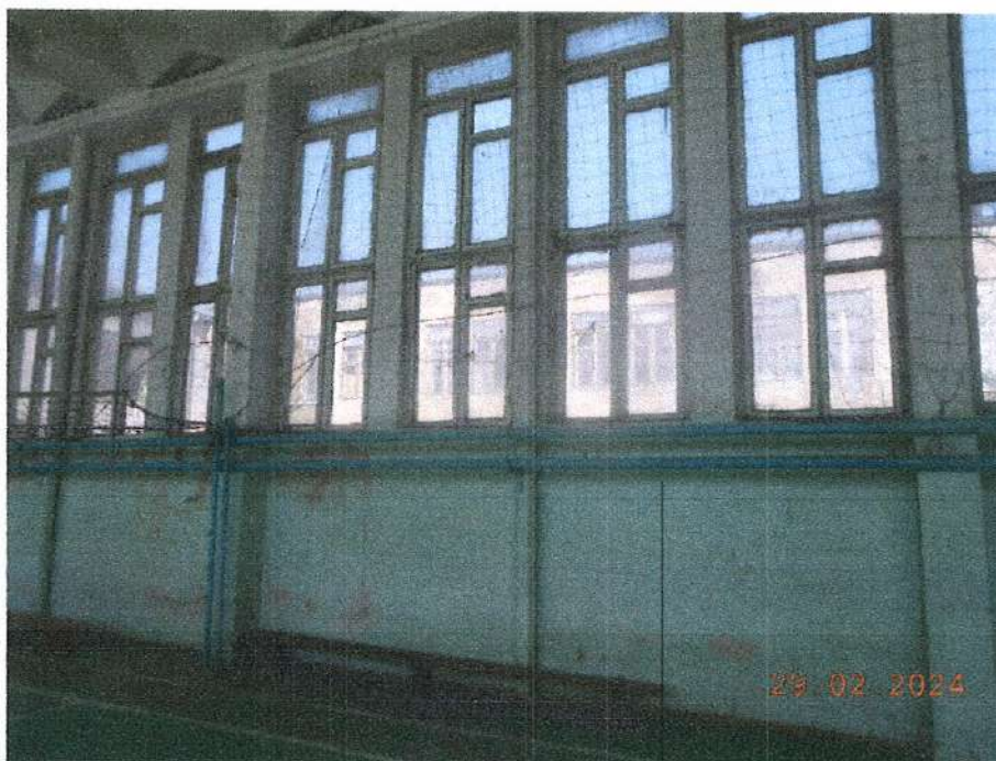
Նկ. 3 Շրջանակների հեծանների միջին տեղամասերում տեղադրված կանգնակների տեսքը
