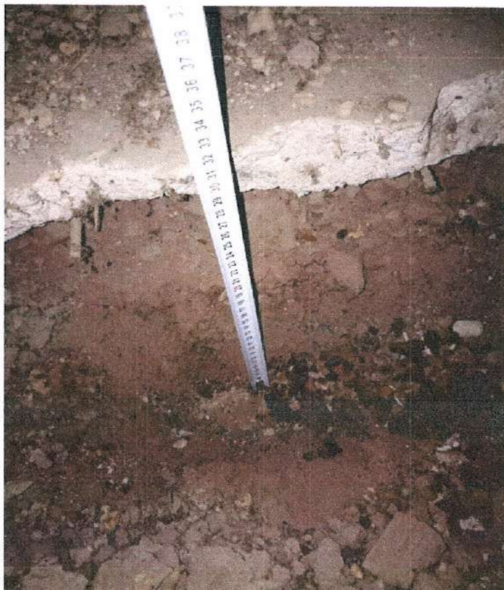
Նկ. 4 Մասնաշենքի տանիքում ջրամեկուսիչ և հարթեցնող շերտերի տեսքը
